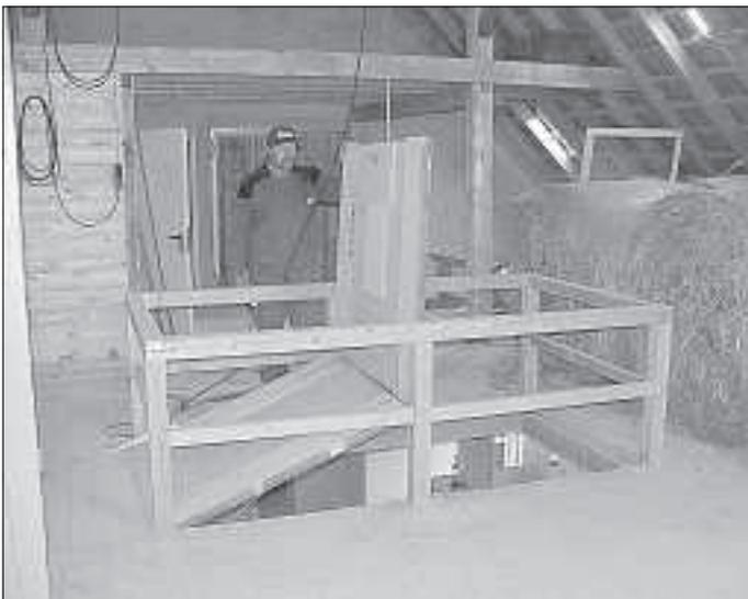
Gut gelöst: Die Abwurföffnung des Bodens auf dem Bild ist optimal abgesichert und durch eine einfach zu bedienende Klappe bei Bedarf auch sicher zu verschließen.
