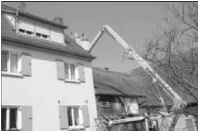
Eine ideale Möglichkeit für Reparaturarbeiten auf dem Dach bietet der Einsatz einer Hubarbeitsbühne, die es mit Auslegern von bis zu 24 Metern gibt, und die stunden- oder tageweise ausgeliehen werden kann.
